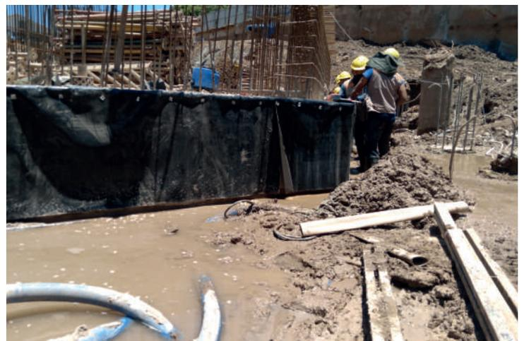
Sistema PARASEAL consta de un polietileno de alta densidad y bentonita granular expandible.
