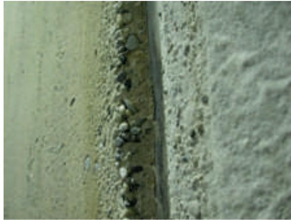
Corrosión del concreto en la zona de gas del tanque de sedimentación final de una PTAR debido al ambiente corrosivo del ácido sulfhídrico ( $H_2S$ ). Foto Planta de tratamiento de aguas residuales Pro Rheno Basilea, Suiza.
