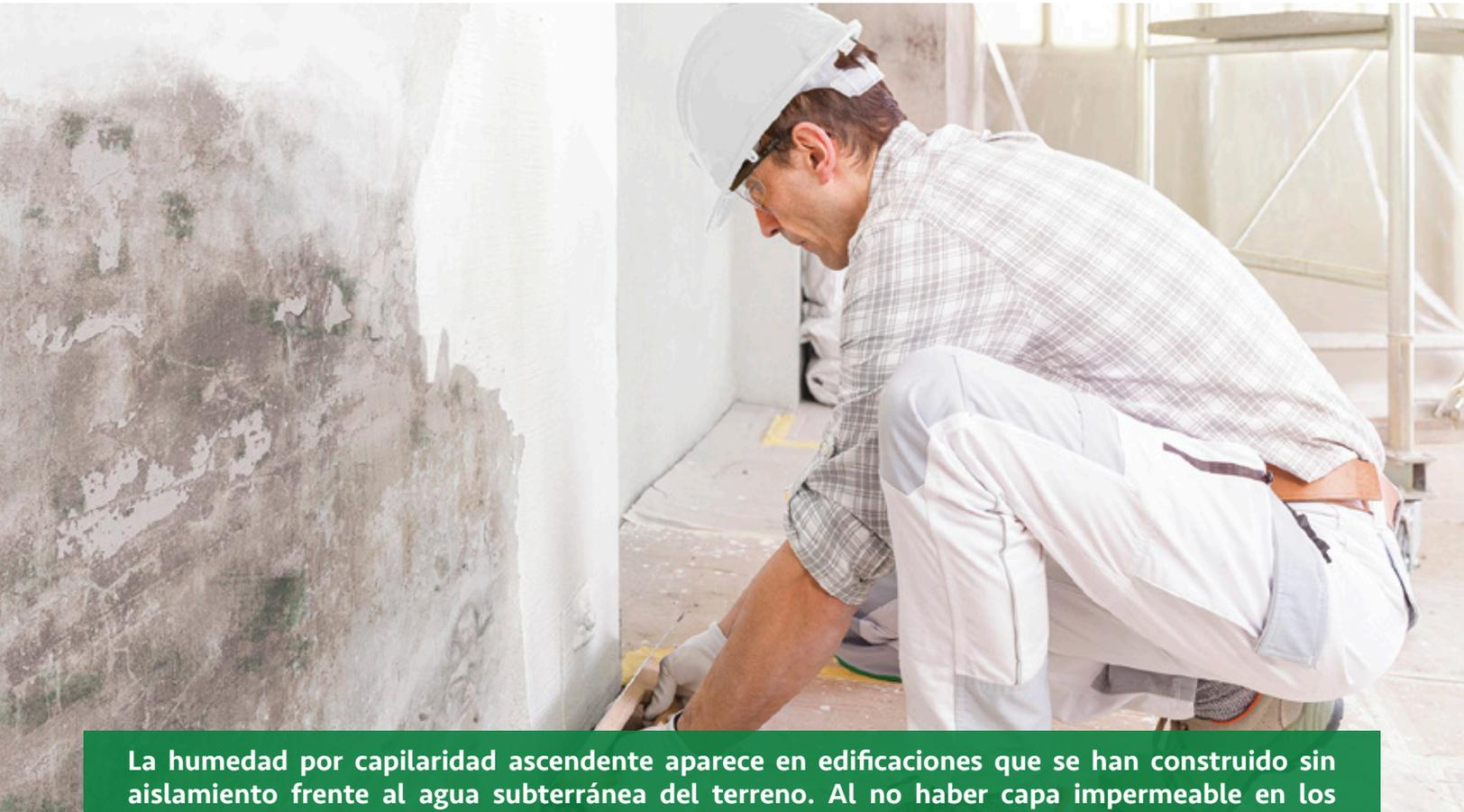
La humedad por capilaridad ascendente aparece en edificaciones que se han construido sin aislamiento frente al agua subterránea del terreno. Al no haber capa impermeable en los cimientos, la humedad que asciende del suelo y por efecto de la adhesión, humedece la pared y comienza su ascensión, crea un ambiente insalubre, con moho y sensación de aire frío.
