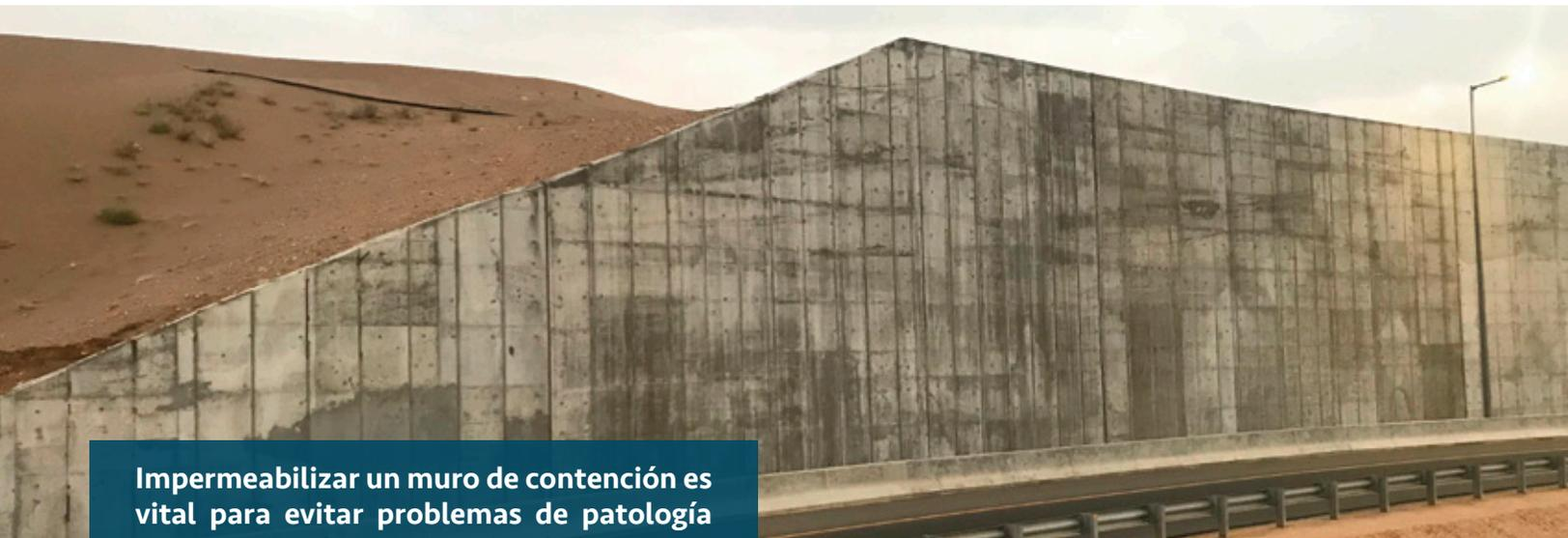
Impermeabilizar un muro de contención es vital para evitar problemas de patología constructiva, la cara interior de los muros de contención construidos en cualquier clase de material deben protegerse de posibles humedades.
