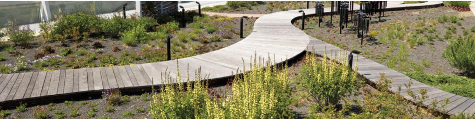
Un techo vegetal está compuesto como mínimo por un soporte estructural, la impermeabilización, una barrera anti raíz, el drenaje, un filtro, el medio vegetal y las plantas. Existen otros elementos que se pueden instalar dependiendo de la necesidad específica del techo vegetal, como es el caso de un aislante térmico. Para proyectos que incluyan cubiertas verdes, nuestro portafolio cuenta con sistemas especializados que se adaptan a sus necesidades.
