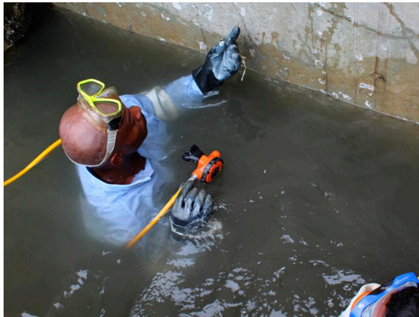
En las áreas que se encuentran deterioradas debido a agresiones biológicas, químicas o físicas y que deban ser removidas para luego continuar con los procesos de reparación y protección, se recomienda utilizar métodos de localización o los planos estructurales para determinar la profundidad, tamaño, cantidad y ubicación aproximada de la armadura en el concreto, esto para no ocasionar daño en el refuerzo, durante las operaciones posteriores.
